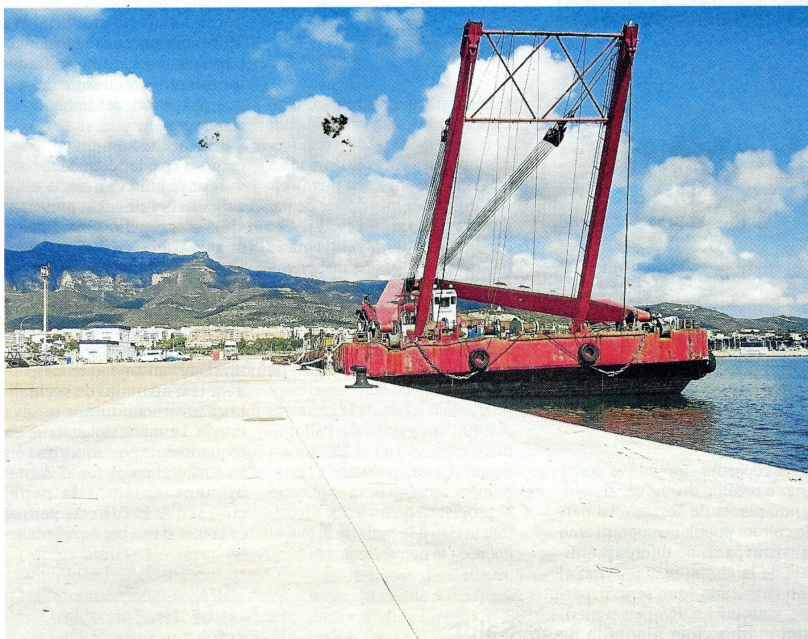
S'ha reforçat el cantell del moll comercial de la Ràpita al llarg dels 465 metres de la infraestructura. FOTO: J.C.
