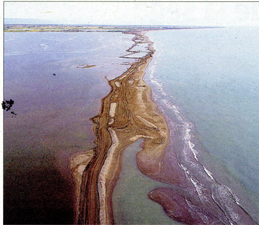
Imatge de la Barra després del petit temporal. S'observa un petit trencament a la part inferior dreta, que obre un petit canal que comunica amb el mar.
