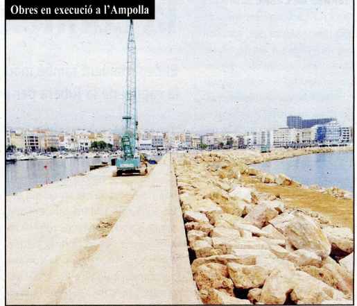
Obres en execució a l'Ampolla
