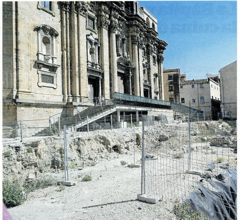
L'espai on s'ha de construir la nova plaça. FOTO: JOAN REVILLAS
