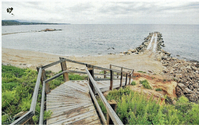
L'espigó es pot veure completament afectat i inundat. FOTO: JOAN REVILLAS
