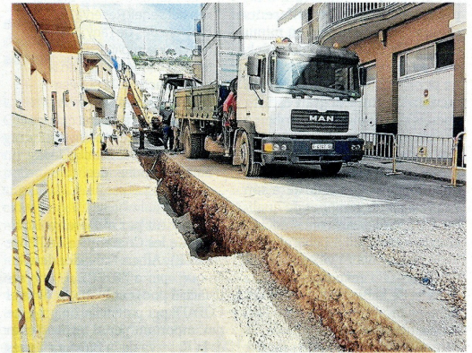
Les obres s'estan duent a terme al centre del municipi. FOTO: CEDIDA
