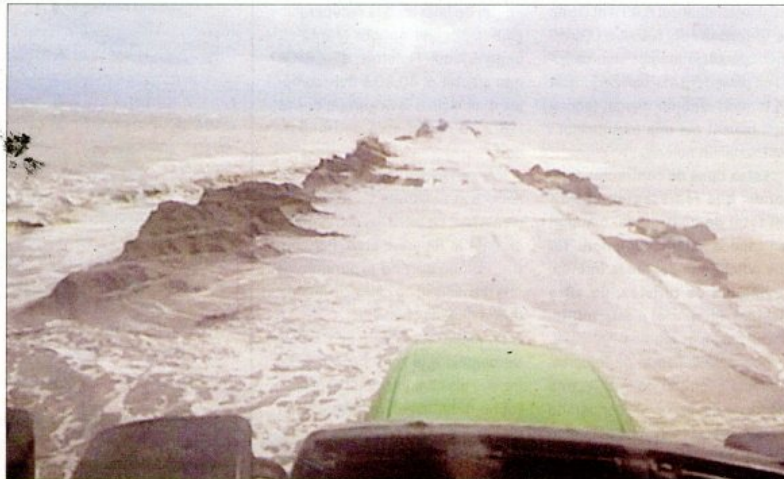
El 8 de maig es va produir l'últim trencament de la barra del Trabucador, moment al qual pertany la imatge. Ara Costes ha decidit restringir-ne l'accés mentre es fan les obres de restauració del braç. / CEDIDA
