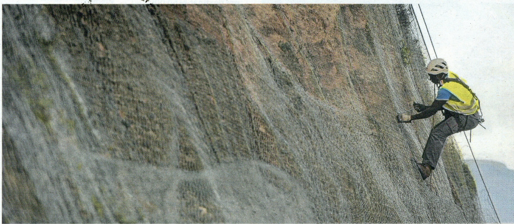
Un operari treballant en els talussos de la C-12. FOTO: JOAN REVILLAS
