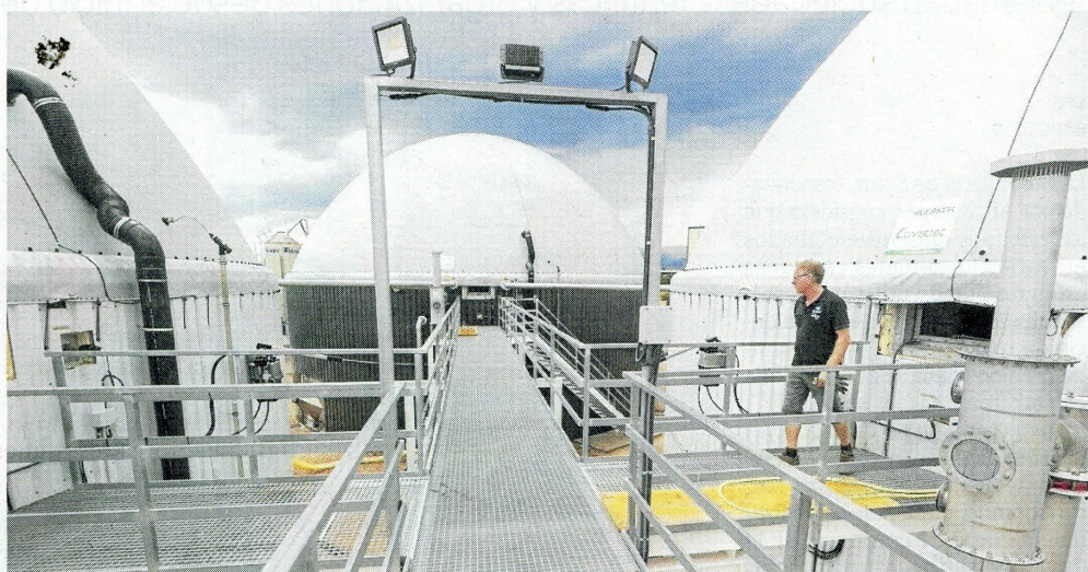
Els digestors de la planta de Biometagás La Galera. FOTO: JOAN REVILLAS
