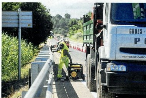
Operaris treballant al llarg de la carretera C-12, a l'altura d'Aldover.
