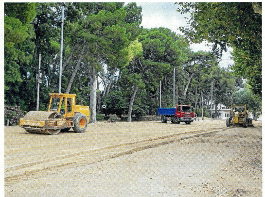
Els treballs duraran fins a la setmana que ve. FOTO: JOAN REVILLAS
