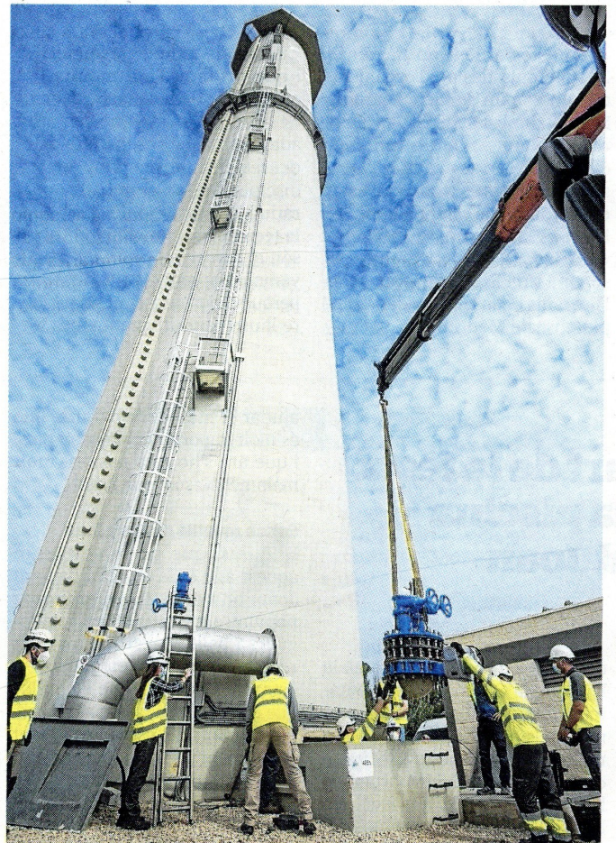
Instal·lant el sistema per revisar tota la canonada. FOTO: JOAN REVILLAS
