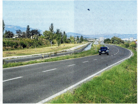
La carretera TV-3408, on s'eixamplarà la calçada. FOTO: JOAN REVILLAS
