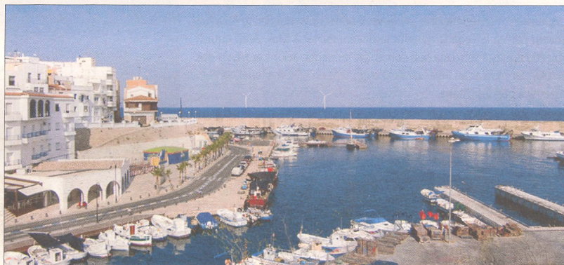
Muntatge de la plataforma a la costa de l'Ametlla de Mar. / CEDIDA
