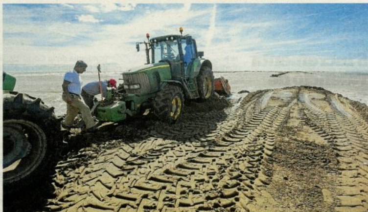
Treballs que s'estan fent a la barra del Trabucador. FOTO: JOAN REVILLAS
