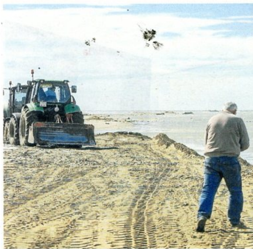
Maquinària treballant a la barra del Trabucador. FOTO: JOAN REVILLAS
