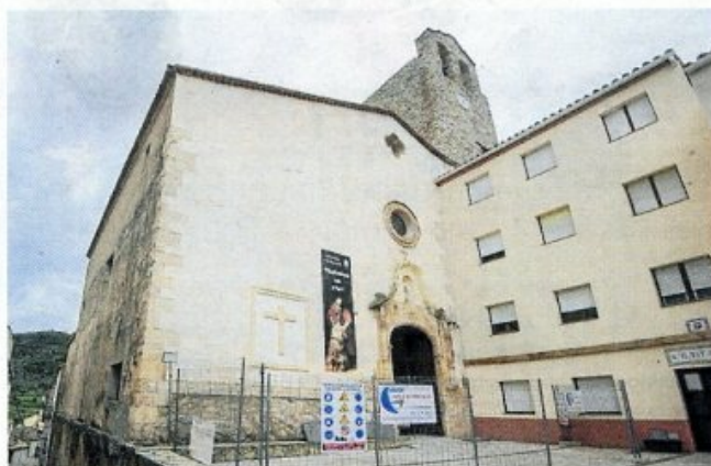
Imatge de la façana exterior del temple religiós, ara en obres.
