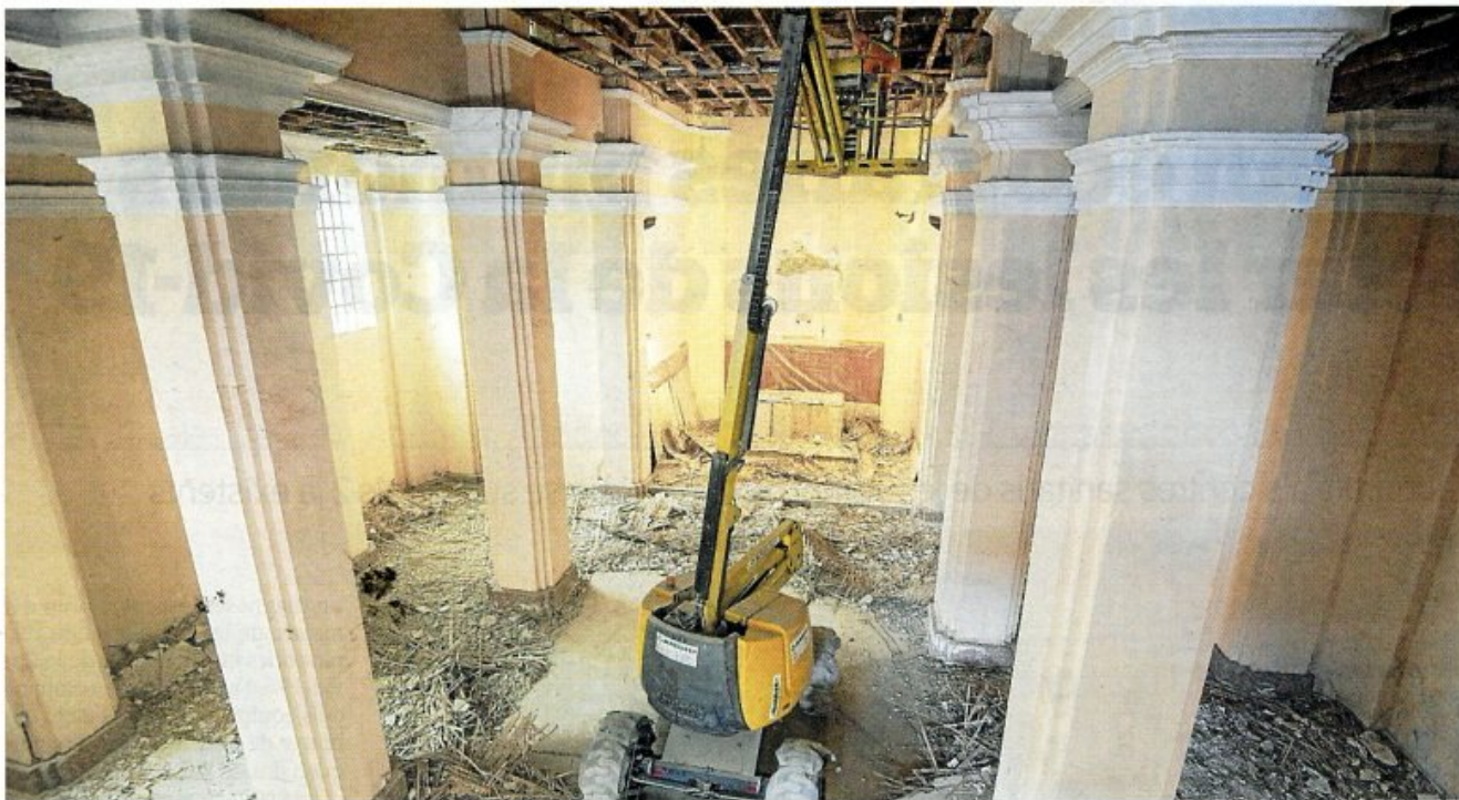
Imatge dels treballs per retirar el cel ras de canyís interior de l'església, aquesta setmana. FOTO: JOAN REVILLAS
