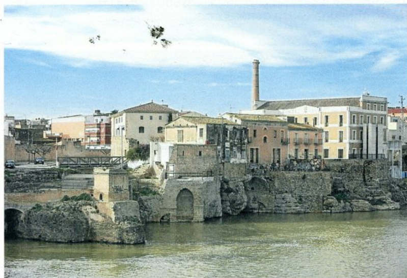
Imatge d'arxiu de la façana fluvial, la rehabilitació de la qual va ser opció guanyadora el 2018. FOTO: J. REVILLAS
