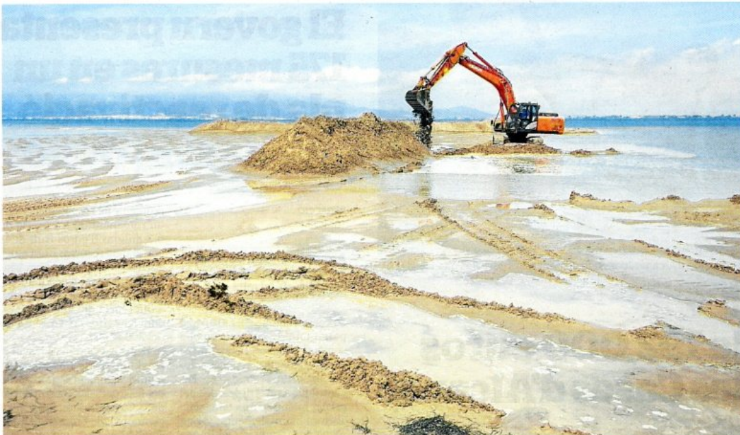
Obres en marxa per refer la barra del Trabucador, a Sant Carles de la Ràpita. FOTO: JOAN REVILLAS
