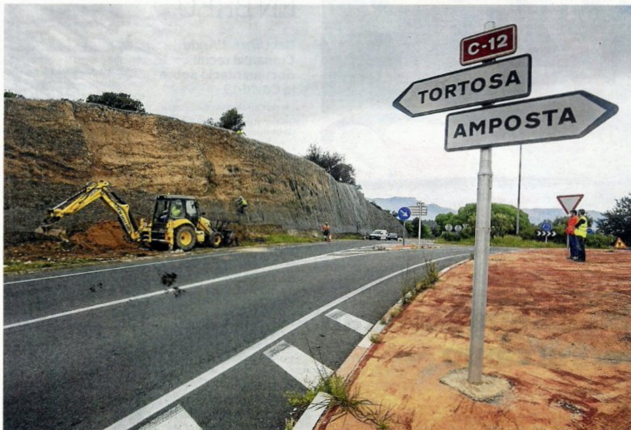
Operaris i màquines treballant aquesta setmana a la C-12, a Vinallop. FOTO: JOAN REVILLAS
