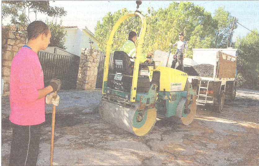
Treballs de reparació de camins, a càrrec d'operaris de l'Ajuntament de Tortosa. FOTO: AJUNTAMENT DE TORTOSA
