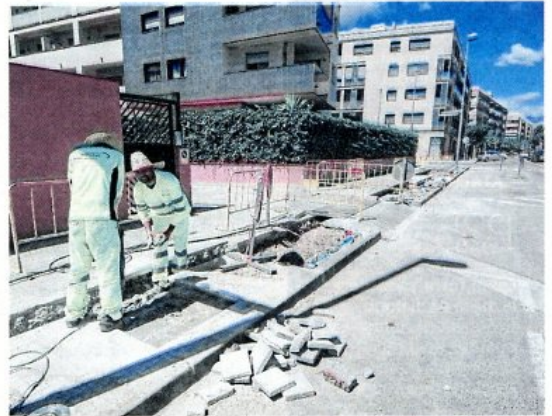
Operaris treballant aquest divendres. FOTO: JOAN REVILLAS
