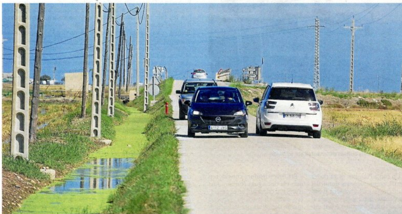
Tram de la conflictiva carretera que connecta la Ràpita amb el Poble Nou, també coneguda com la «carretera de la vergonya». FOTO: JOAN REVILLAS
