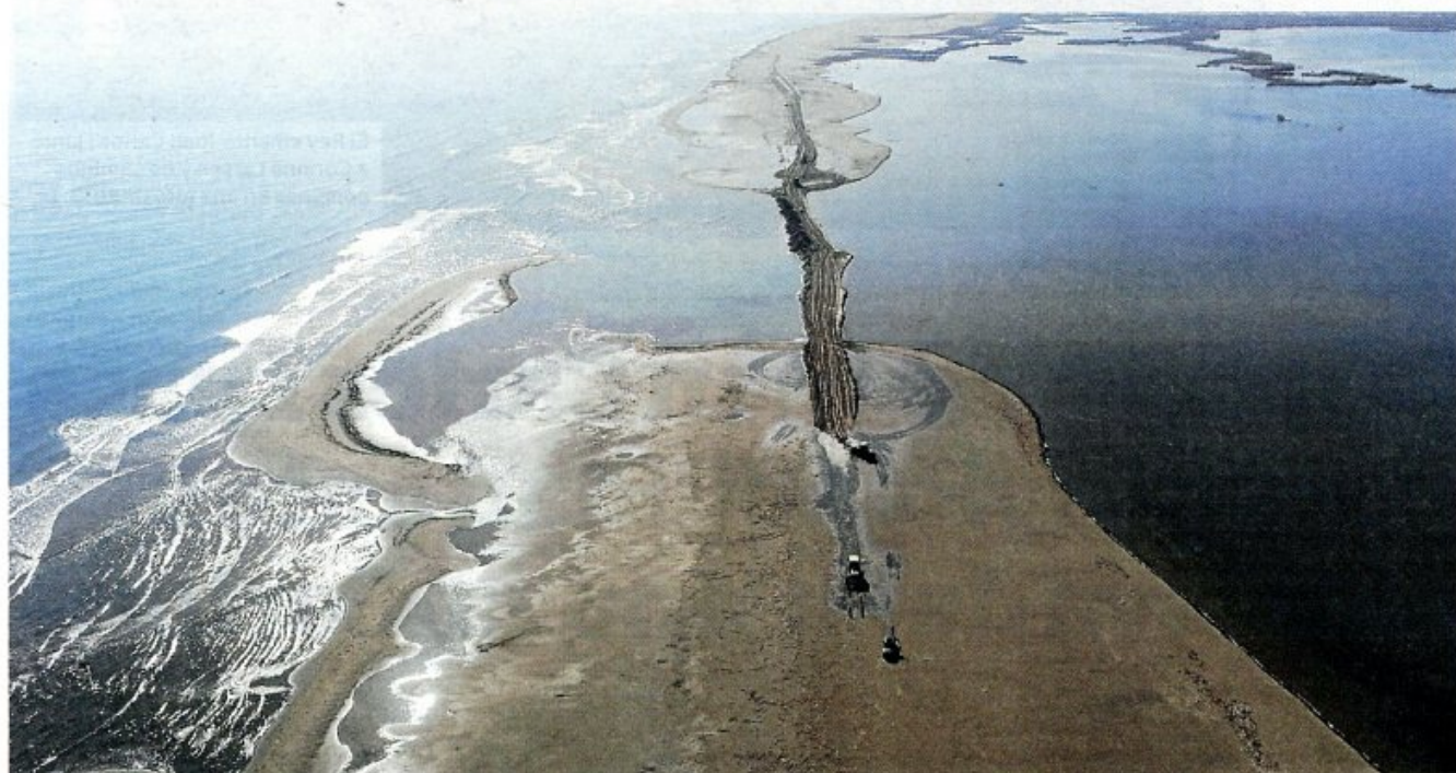
Les obres realitzades a l'illa de Buda per crear un cordó d'arena i tancar la llacuna. FOTO: CEDIDA
