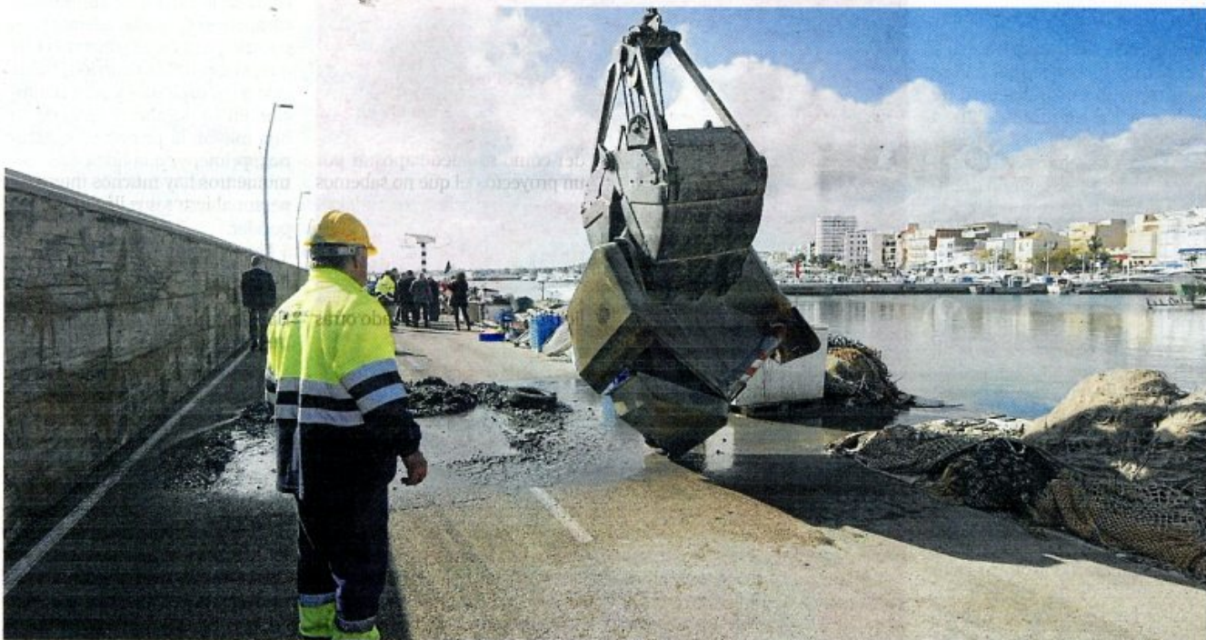
Imatge d'arxiu del mes de febrer amb operaris treballant per millorar l'estat del port de l'Ampolla després del Glòria. FOTO: JOAN REVILLAS
