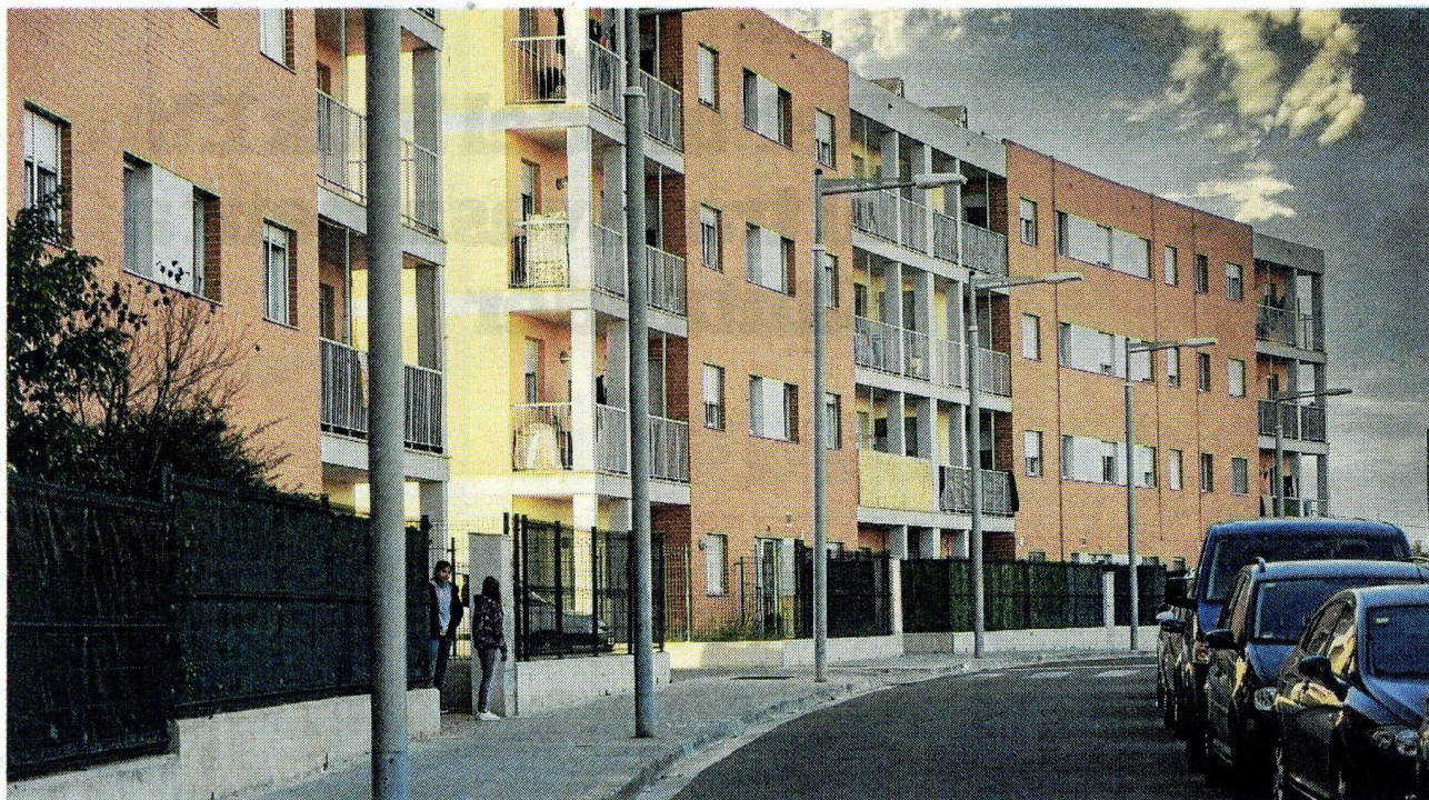
Alguns dels pisos del parc d'habitatge públic d'Ampostà. FOTO: JOAN REVILLAS
