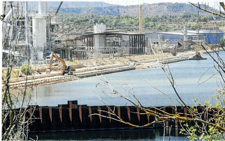
Obres de restauració del marge fluvial. FOTO: JOAN REVILLAS
