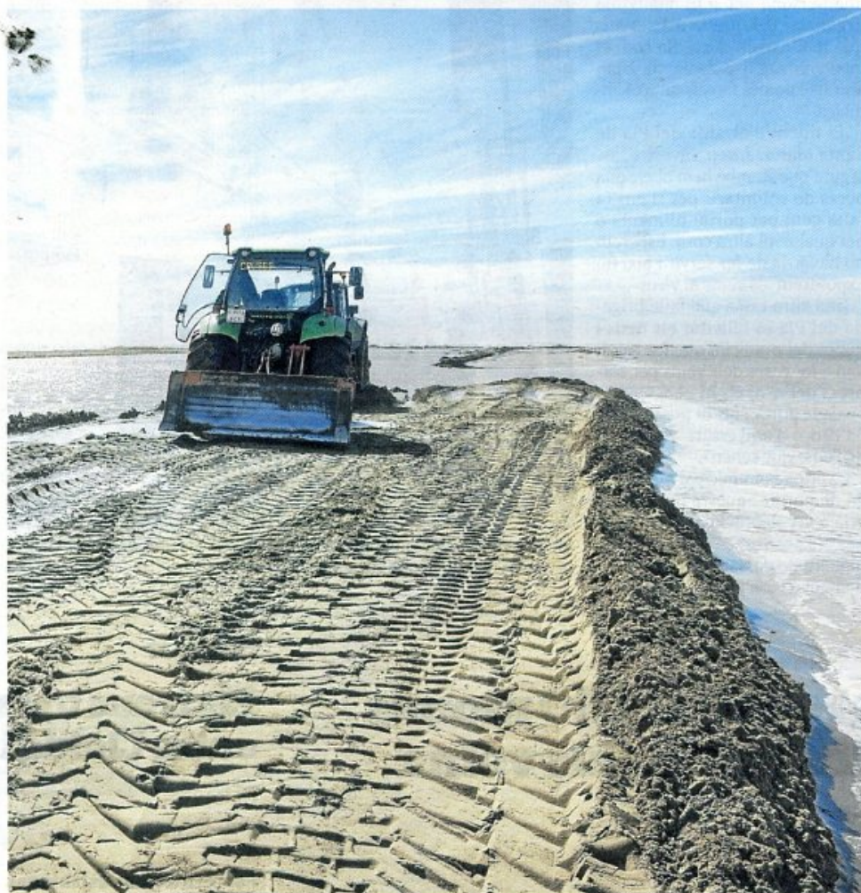
Màquines treballant a la barra del Trabucador per refer el camí que accedeix a les Salines. FOTO: JOAN REVILLAS
