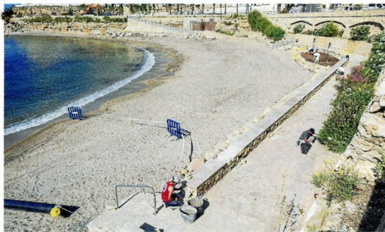
A més a més, també s'estan realitzant treballs per reparar altres danys causats pel Glòria. FOTO: JOAN REVILLAS
