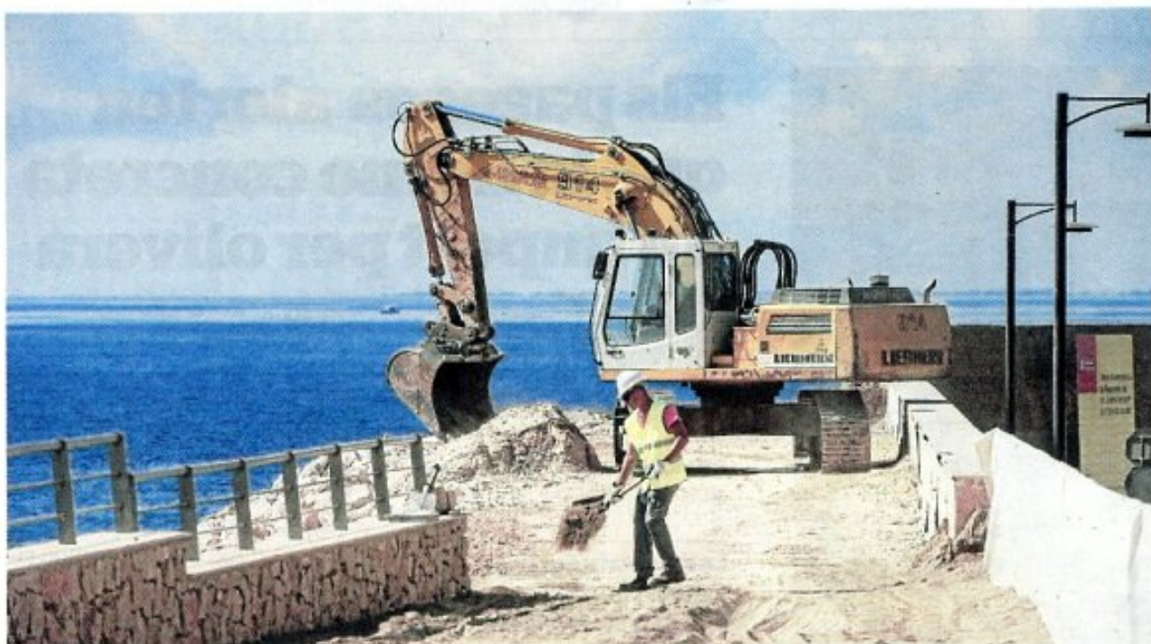
Operaris als treballs de Ports de la Generalitat al port de l'Ametlla, ahir al matí. FOTO: JOAN REVILLAS
