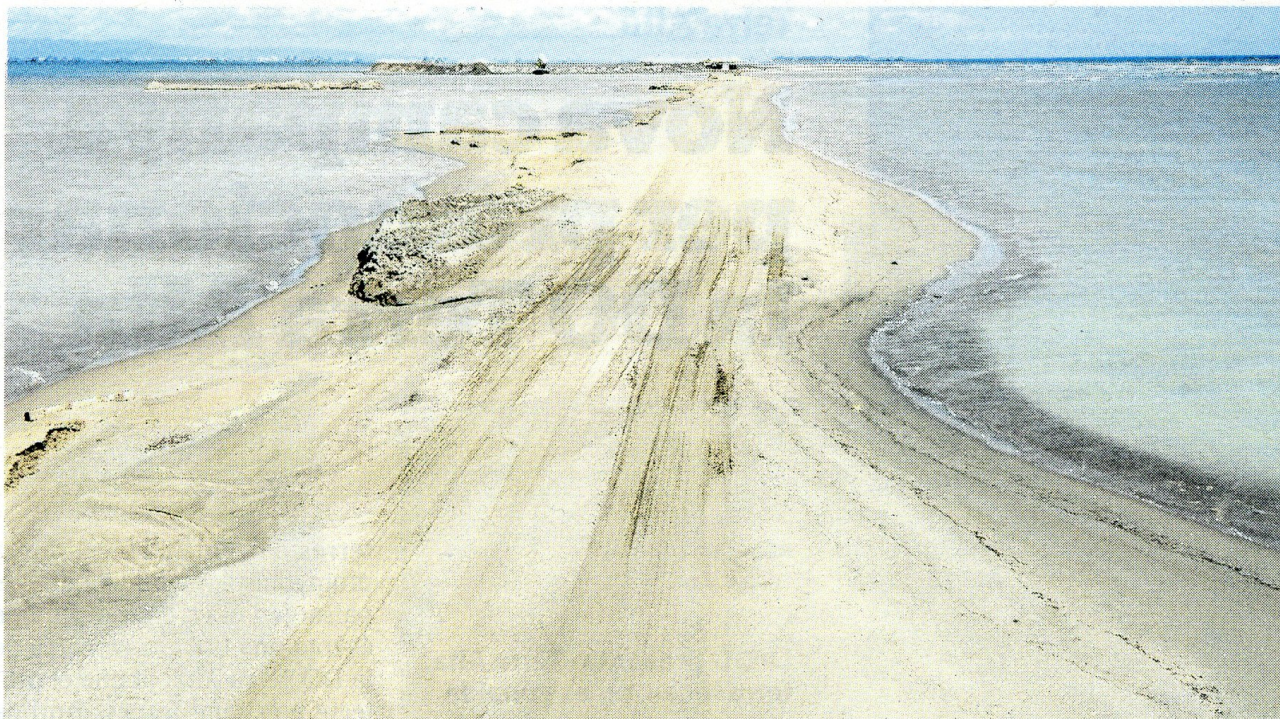
Imatge de fa uns dies dels treballs a la barra del Trabucador. FOTO: JOAN REVILLAS
