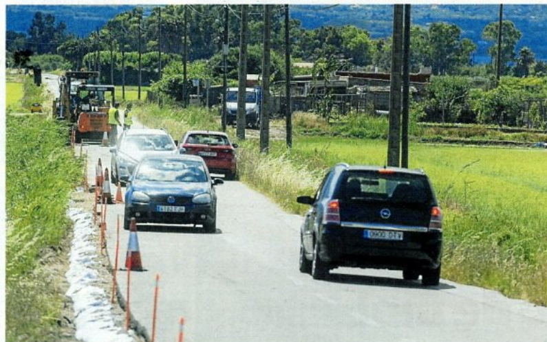
Imatge de les obres ahir, on es pot veure com és d'estreta la carretera. FOTO: JOAN REVILLAS
