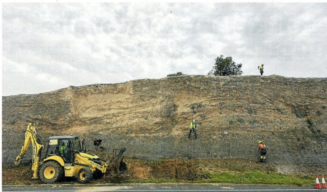
Estabilització dels talussos de la C-12 a l'altura de Vinallop, al terme de Tortosa. FOTO: JOAN REVILLAS
