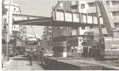
Les obres de desmuntatge del pont del tren a l'av. de la Generalitat o vora el riu.
