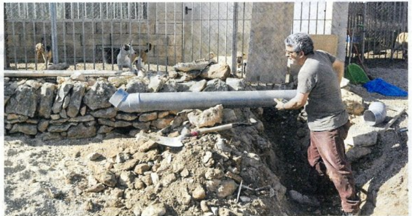
Un obrer instal·la una canonada per a l'aigua residual, davant la mirada atenta dels gossos. FOTO: J. REVILLAS
