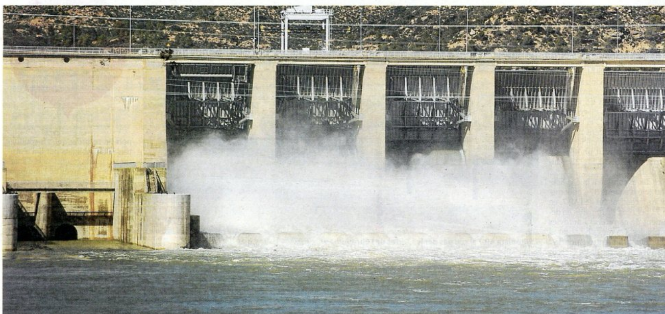
Imatge de l'actual central hidroelèctrica al pantà de Riba-roja d'Ebre, a la Ribera d'Ebre. FOTO: JOAN REVILLAS
