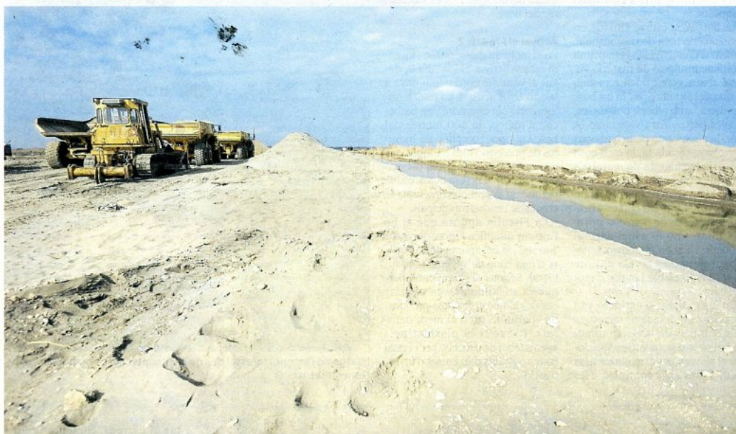
La maquinària que treballa portant arena a l'illa de Buda. FOTO: JOAN REVILLAS
