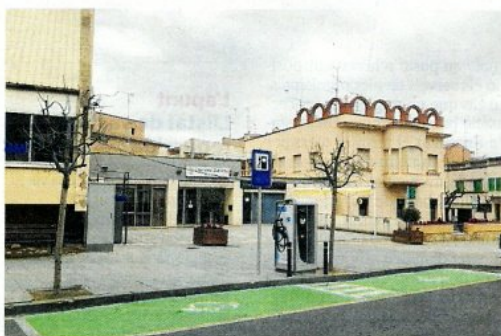
Imatge del punt de recàrrega ràpida de vehicles elèctrics a l'avinguda Comarques Catalanes. FOTO: AJUNTAMENT DE MÓRA D'EBRE
