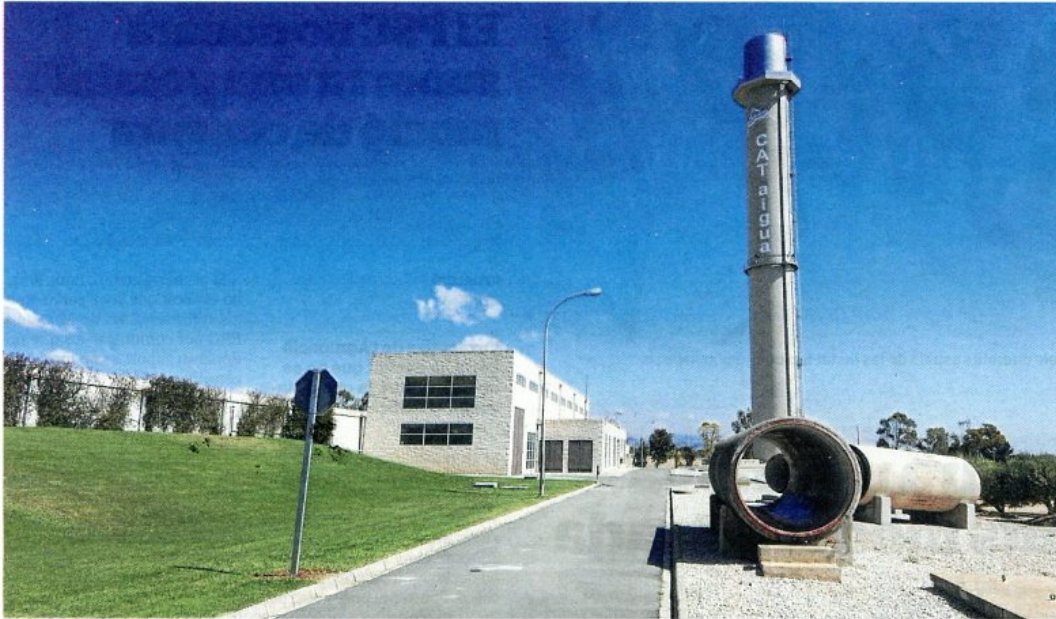
Les instal·lacions que el Consorci d'Aigües de Tarragona (CAT) té ubicades al municipi de l'Ampolla, en una imatge d'arxiu. FOTO: JOAN REVILLAS
