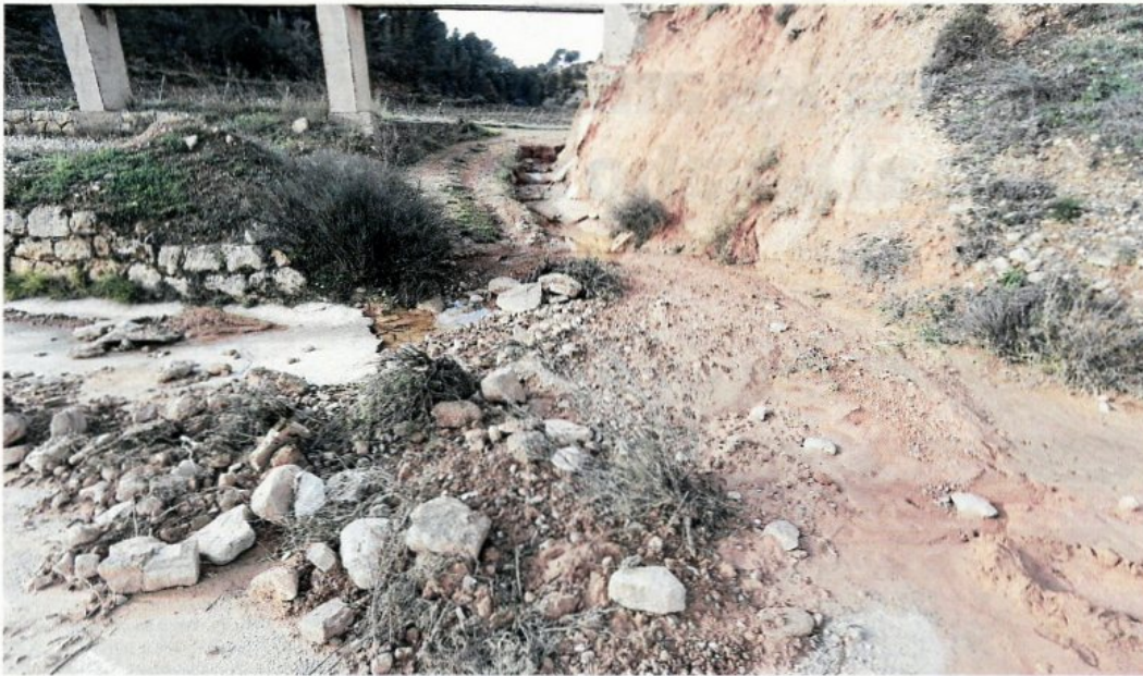
Imatge d'un dels múltiples camins rurals afectats al terme de Bot, ahir a la tarda. FOTO: JOAN REVILLAS
