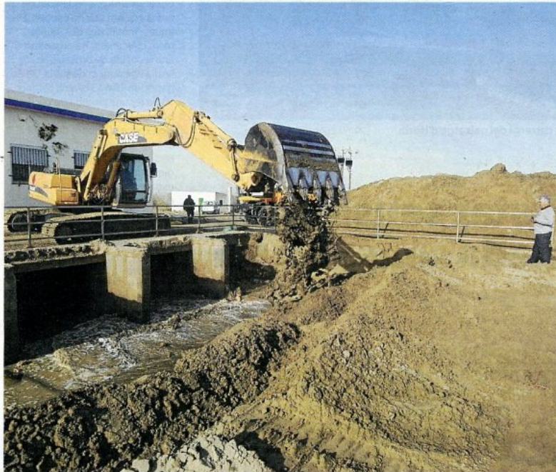
Màquines excavadores retirant tones d'arena acumulades a l'estació de bombeig de Pal. FOTO: JOAN REVILLAS
