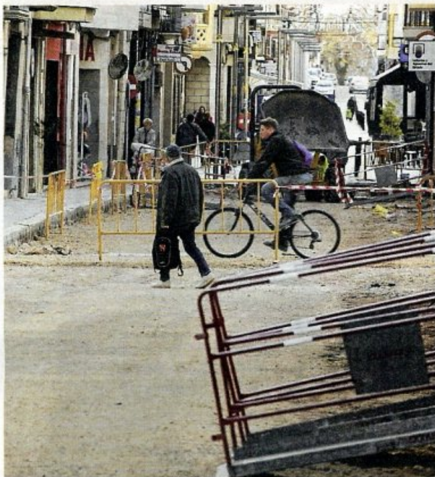
El carrer Major d'Uldecona, al nucli antic del municipi, amb el paviment aixecat i en obres, en una imatge d'arxiu. FOTO: JOAN REVILLAS
