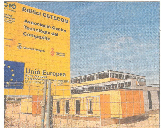
Estat de les obres del nou centre tecnològic al polígon d'Oriola de la capital del Montsià la setmana passada. FOTO: A. GARALT
