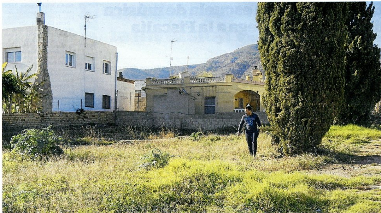
Josep Fibla mostra l'estat de la urbanització Montecarlo, a Alcanar Platja. FOTO: JOAN REVILLAS
