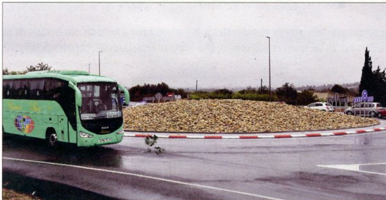
La rotonda del Perelló, una de les primeres que es va construir al tram ebrenc de la nacional. / N. CARO
