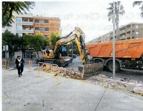
Treballs en marxa a la zona de Vora Parc. FOTO: JOAN REVILLAS
