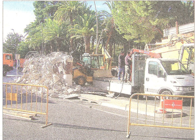
Treballs per enderrocar la pilastra de l'antic pont del tren sobre l'avinguda Generalitat. FOTO: M. MILLAN
