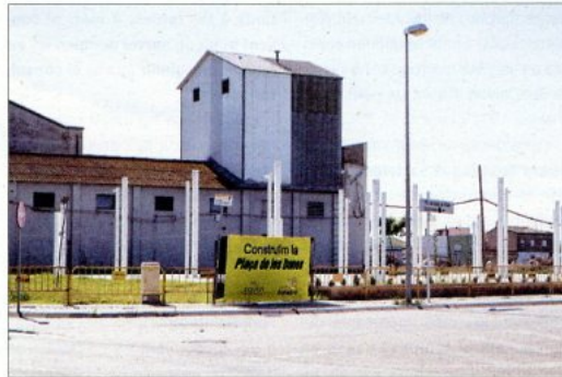
Les obres de la plaça de les Dones estan aturades des de fa 5 mesos.
