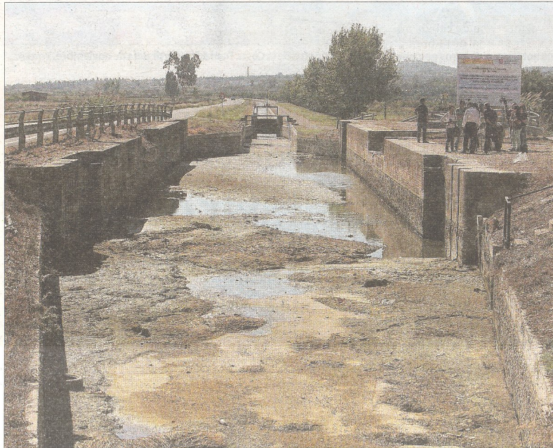
El canal marítim s'ha buidat per facilitar l'eliminació dels caragols. FOTO: EFE
