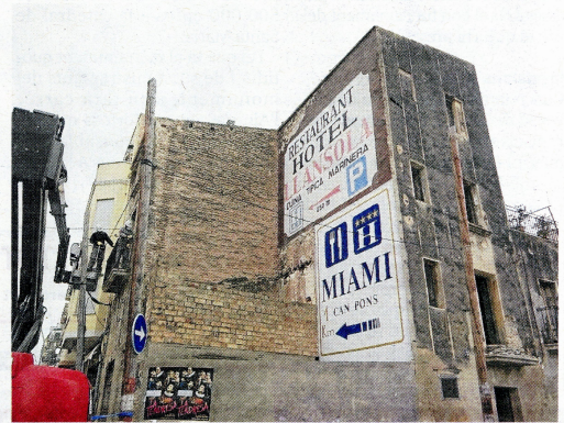
Obres d'enderroc, ahir. FOTO: JOAN REVILLAS
